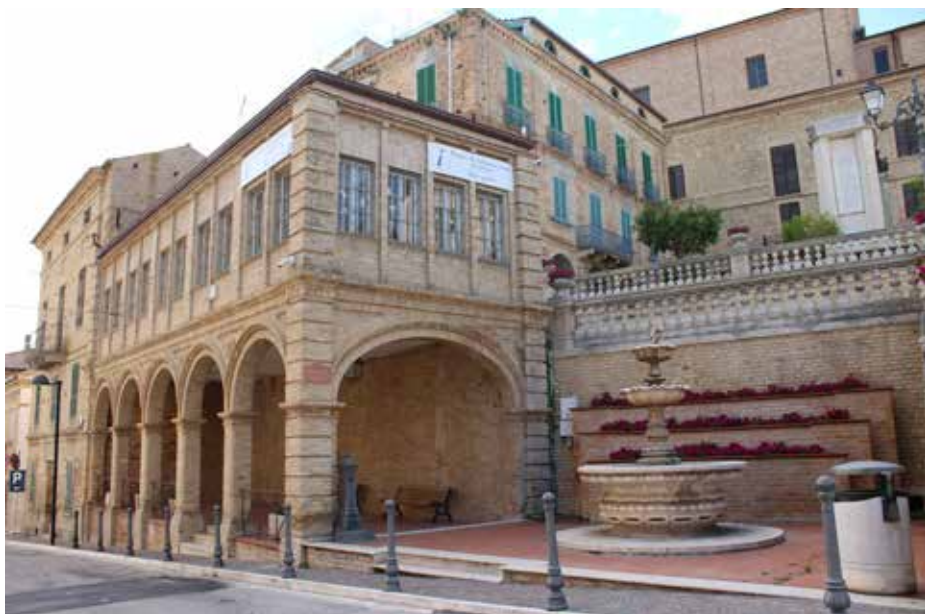
Colonnella: il lavatoio
